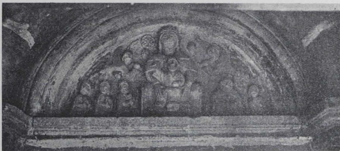
Fig. 699. — Portal de l'església de Mura
