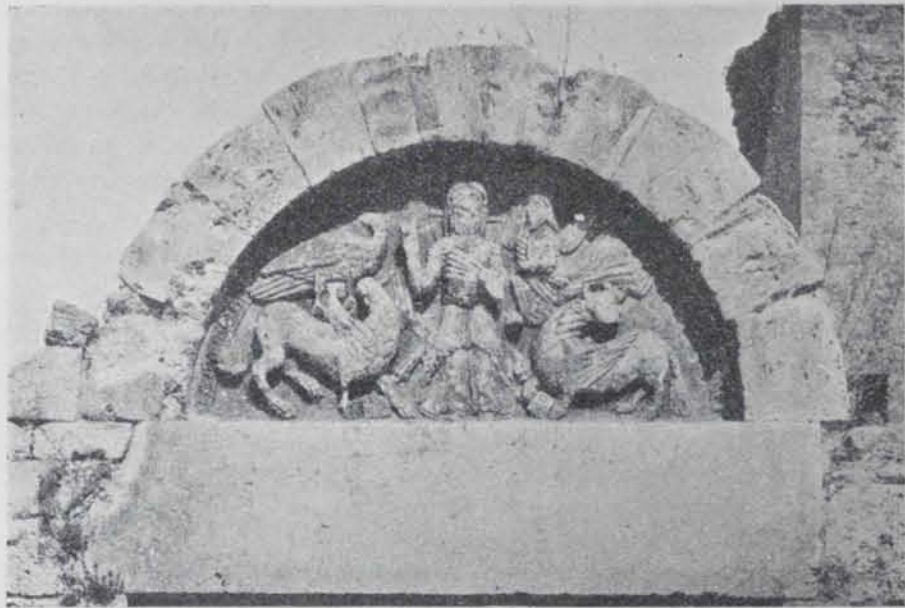
Fig. 700. — Portal de l'església de Santa Maria de Besalú
